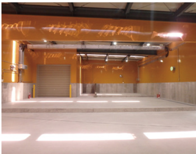
堆肥化施設 内部
